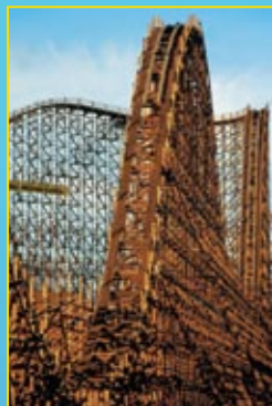
Colossos , Heide Park Soltau Deutschland, 2001 Holzstruktur inkl. Montage
