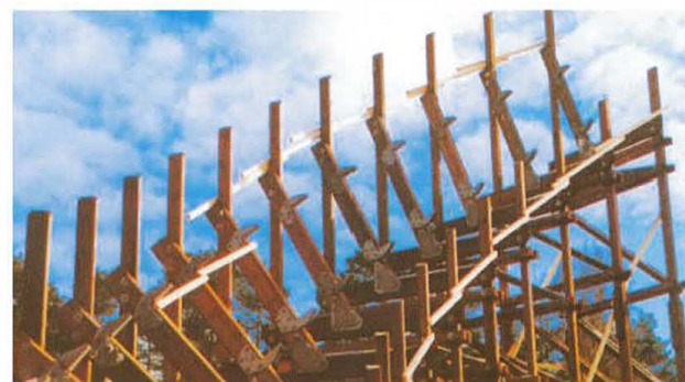
Abb. 5 Ledger-Anordnung im Kurvenbereich
