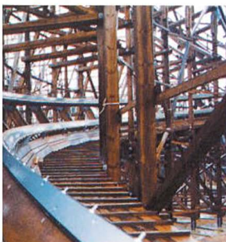
Abb. 7 Schienenaullagerung auf den „ledgern“
