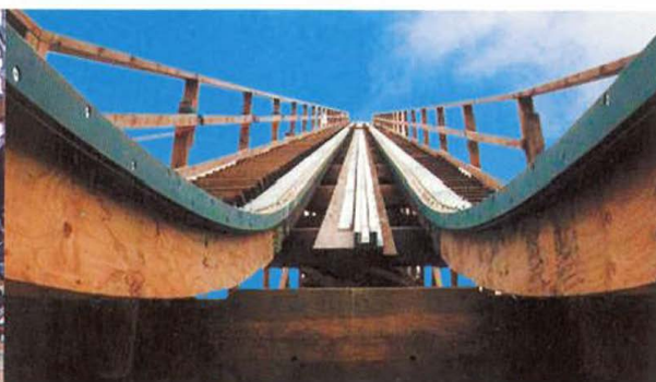
Abb. 8 Deutlich sind die Schienen aus Furnierschichtholz zu sehen
