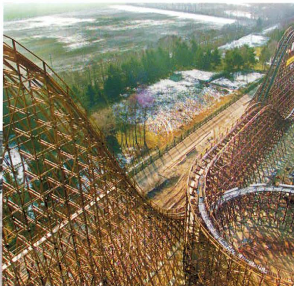
Abb. 11 Blick von der Rampe
