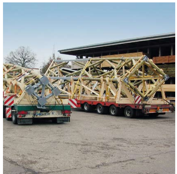
▼ Transport der vormontierten Schwanzkonstruktion zur Baustelle
