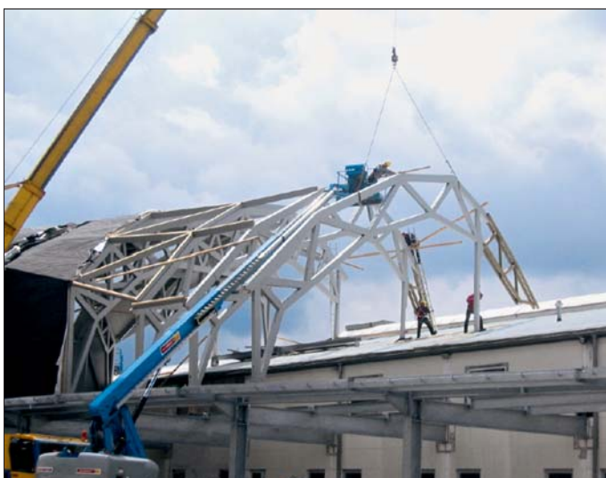
Im Werk vormontierte Teile des Geckoschwanzes, der später frei über den Dächern der Manufaktur schwebt
