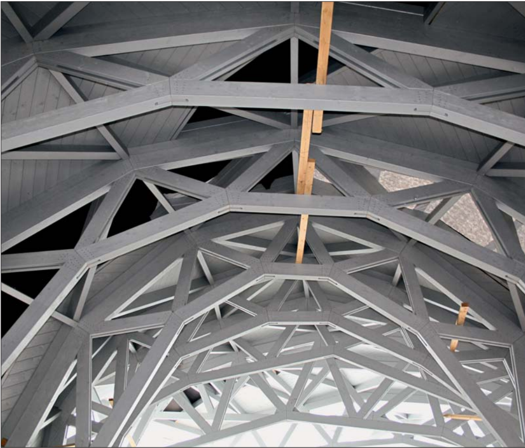
Aus 21 Fachwerkträgern besteht die Haupttragkonstruktion des Tierpumpfes (Fotos: Cordes)
