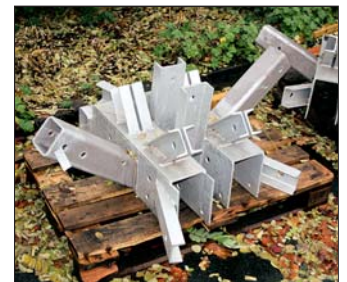
Komplexer Stahlknoten, wie er sich im frei bewitterten Übergangsbereich zwischen Rumpf und Schwanz findet
