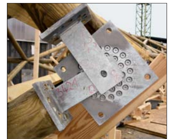
Die Art der Befestigung der Beschläge an den Stirnseiten der Schwanzrundhölzer bedurfte der bauaufsichtlichen Zulassung im Einzelfall
