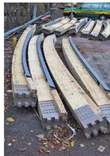
▲ Scharnierähnlich ausgeführte Stahlanschlussteile zur Verbindung der Schienenabschnitte
