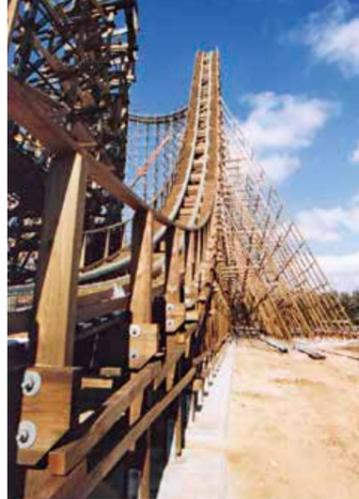
▲ Die Fachwerke erhalten jeweils Einzelfundamente. Fußanker und Grundplatte nehmen die Stützen auf
