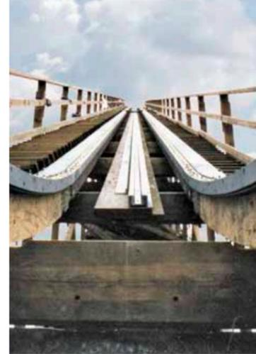
▲ Schienenkörper aus Furnierschichtholz erfüllen alle geforderten Eigenschaften, vor allem Witterungsbeständigkeit
