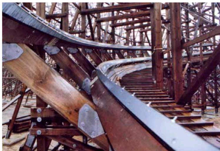
▲ Auf den sogenannten „Ledgern“ wurden die Schienenkörper über spezielle Stahlschuhe montiert. Die Schienenverwindungen sind auf der 1500 m langen Strecke überall unterschiedlich. Daher wurden die Schienen abschnittsweise als Einzelteile vorgefertigt
