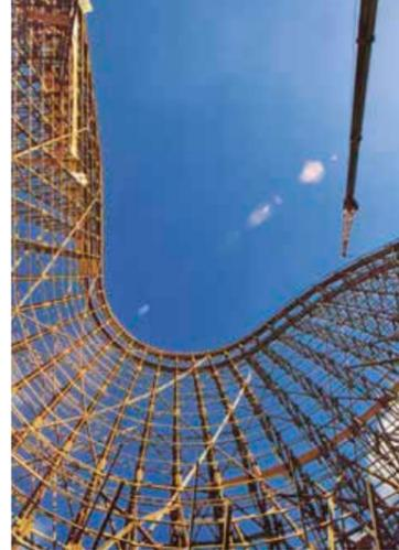
▲ Quer verlaufende Diagonalen bilden ein rautenförmiges Netz zur Aussteifung in Bahnrichtung
