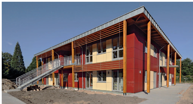
Bild 5. Kindertagesstätte Sodenkamp 3 in Hamburg Klein-Borstel: außenliegende Rettungstreppe aus dem Obergeschoss
