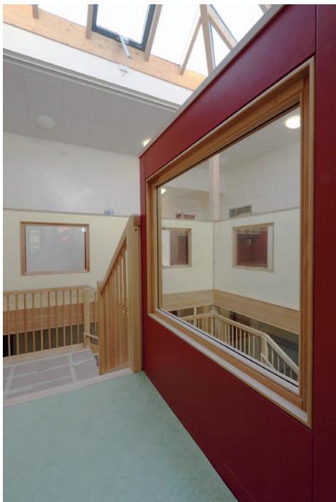
Bild 7. Die großzügige, offene und lichtdurchflutete Eingangs- und Spielhalle erstreckt sich über zwei Geschosse und ist mit einer ca. 18 m 2 großen Glaspyramide mit öffentbaren Lüftungsflügeln mit RWA-Funktion überdacht
