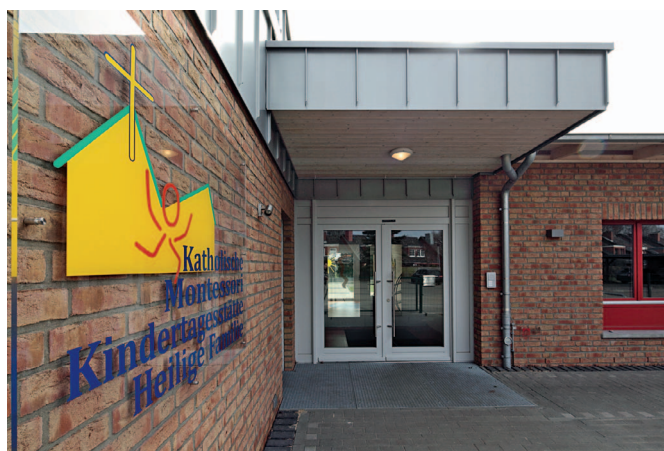
Bild 1. Katholische Montessori-Kindertagesstätte Heilige Familie in Hamburg-Langhorn: Außenwände aus Konstruktionsvollholz mit Mauerwerksverblendschale
