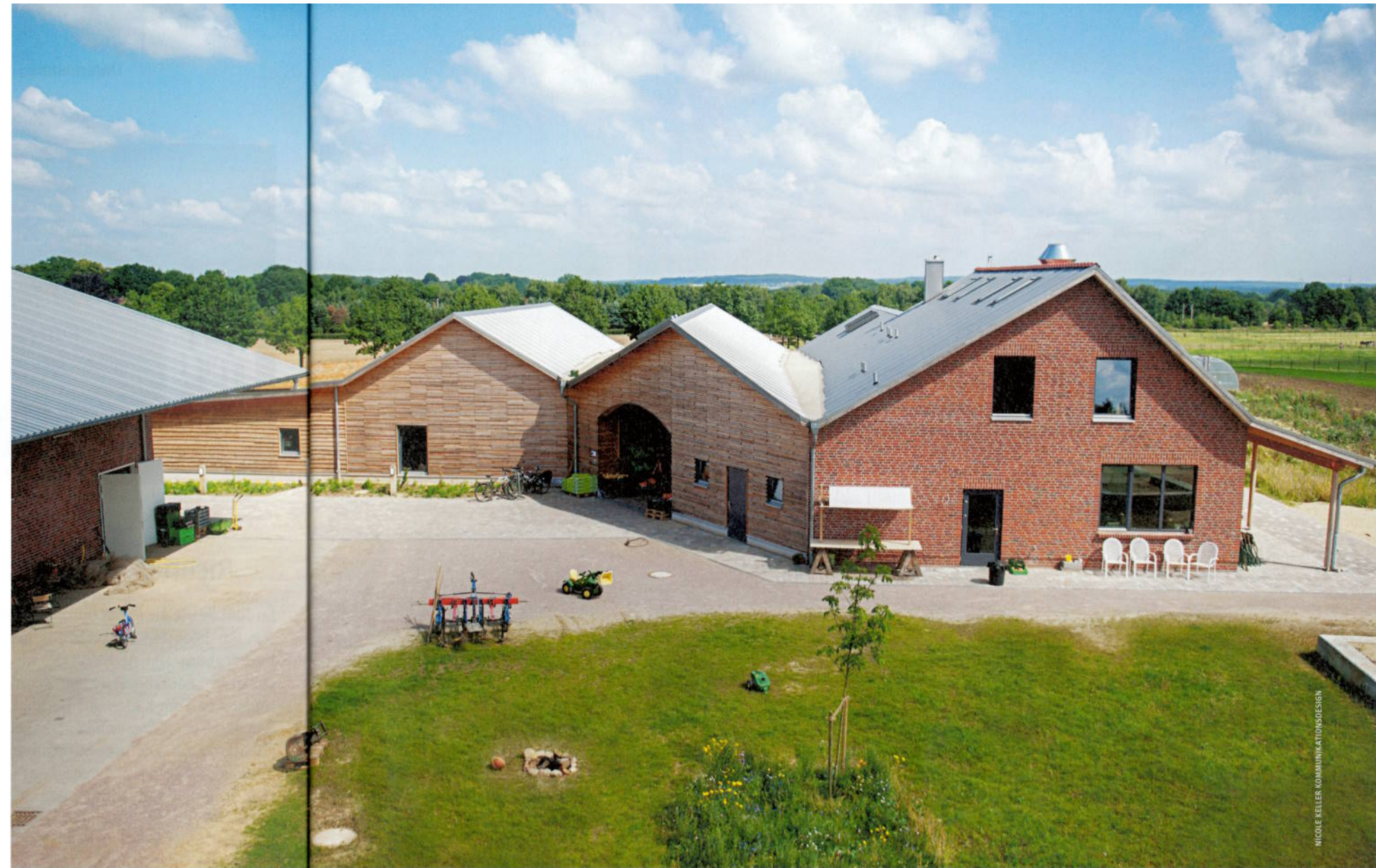
► Mustermix: Jedes der Gebäude hat eine andere Fassade aus Holz
